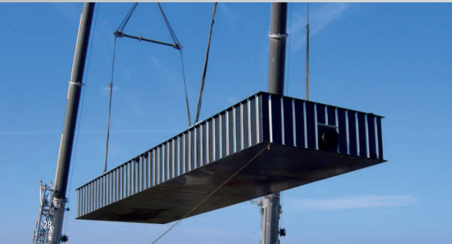
geschlossener Behälter (Dach und/oder Boden als Zuganker)
